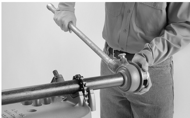
Figura 3 – Montaje de la Roscadora en el tubo
